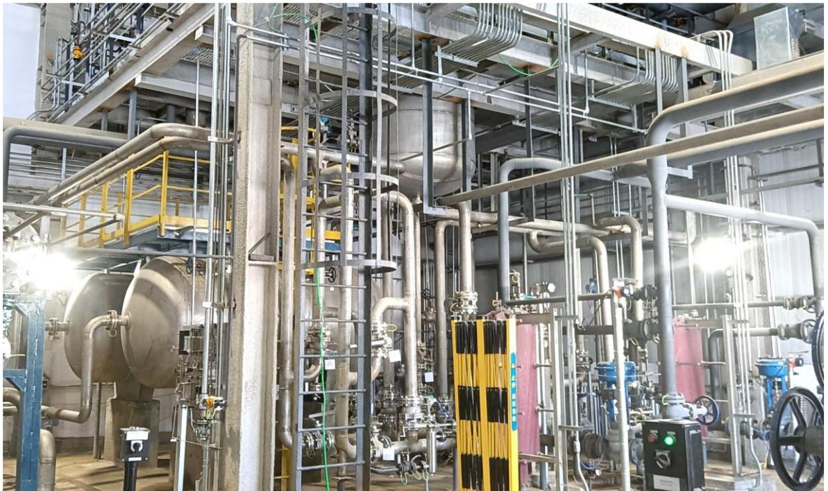
上海艾克森提供的板式换热器、全焊接板式换热器及高效换热机组等产品分别用于核心工艺电解水制氢、提纯气液分离、工艺水冷却和碱水制氢系统。电解槽电解液温度超 80℃时，板式换热器借助冷却水循环快速降温，维持最佳反应效率；针对电解产生的、含水分的阴极氢气与阳极氧气，通过板式换热器冷却使水分冷凝分离提升气体纯度；同时，装置内配置成套撬装循环除盐水系统（冷源为工业循环水），集成除盐水循环泵、冷却器、过滤器等设备，用于冷却整流柜系统，且该撬块占地小、运行稳定。其中，针对碱水制氢场景，电解槽阴极氢气（含水蒸气、碱雾）经艾克森全焊接板式换热器降温，冷凝水通过气液分离器分离，可降低后续干燥设备负荷、避免高温损害氢储存压缩设备；阳极氧气（含同类杂质）经同款换热器处理，既能防止水分腐蚀管道阀门、满足后续使用或排放温度要求，分离的冷凝水还可回用电解系统，提升水资源利用率并减少碱液流失对环境的影响。上述换热产品和解决方案不仅提升项目能源转换利用效率，保障绿氢制备及绿氨合成高效稳定运行，更在节能减排中发挥关键作用，有效降低项目整体能耗与碳排放。
