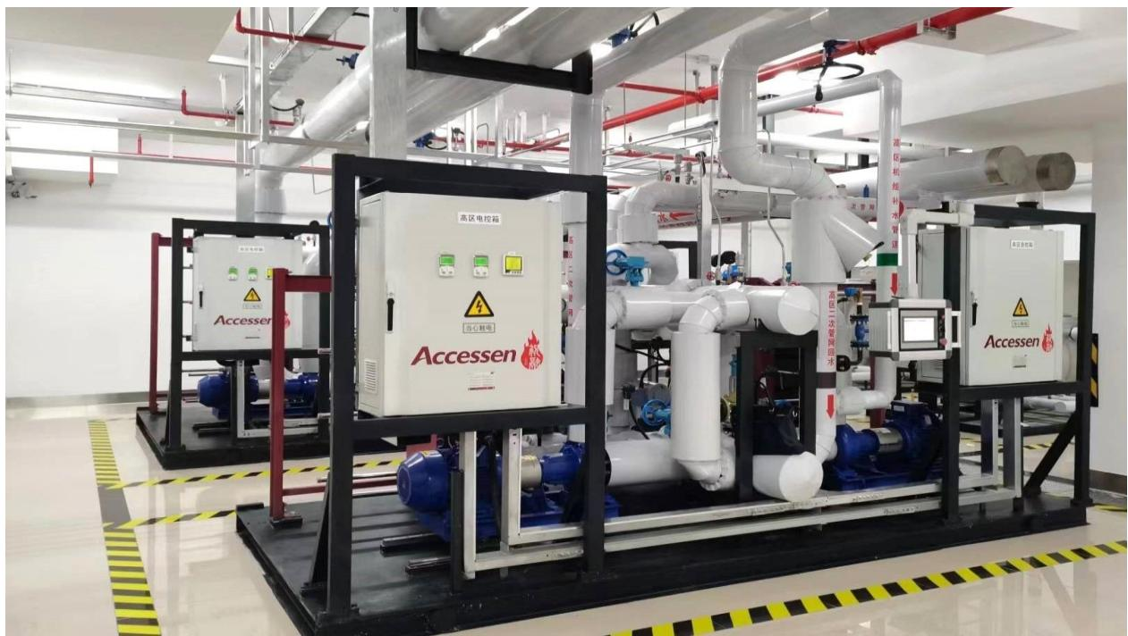
经过华能日照热力多方考察及论证后，最终在传统板式换热机组的基础上精简采用了6个规格的标准模块化机组系列，此标准系列换热模块通过单台使用、两台并联使用及三台并联使用，达到覆盖85%以上供热工况，解决热力企业使用的设备型号及备品备件过多、管理成本过高、运行成本过大的缺点，标准化后各个热力站设备互换性有了很大的提升，通过标准生产和供应实现热力站的快速安装和投运。
