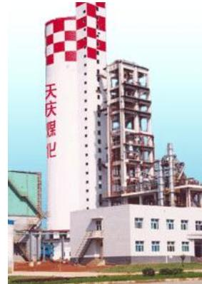
该项目装置区位于河南沁阳市沁北工业集聚区，一期工程占地 1000 亩，以 15# 煤为原料，采用国际国内先进的碎煤加压气化工艺、低温甲醇洗及液氮洗净化工艺制合成氨，选用 CO<sub>2</sub> 气提工艺生产尿素，建成一套年产能为 18 万吨合成氨、30 万吨尿素、5 亿 m<sup>3</sup> 工业燃气的煤化工生产装置。投产后，不仅能为河南省及周边地区粮食生产提供充足的化肥资源保障，还将为沁北工业园区诸多燃气用户提供煤制燃气。
